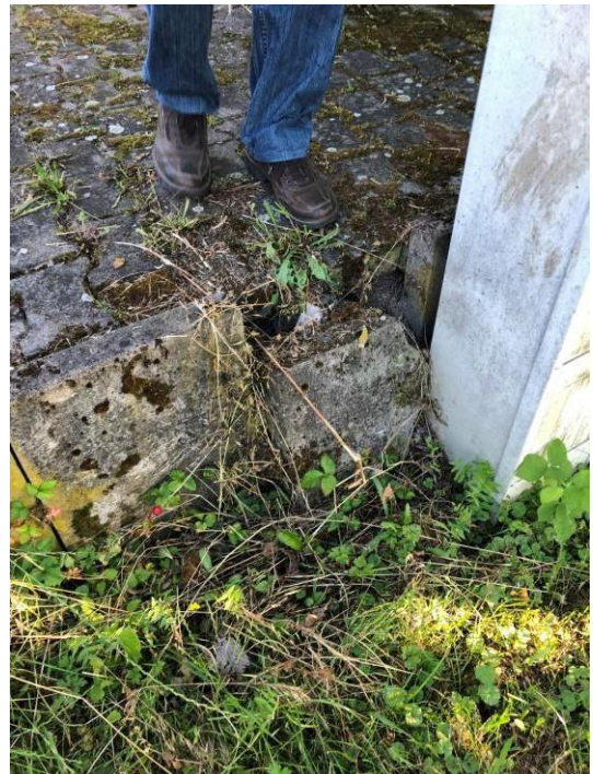
L-Stein Trafohaus Bornfeldstraße
