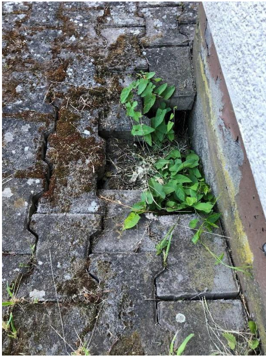
Pflaster Trafohaus Bornfeldstraße
