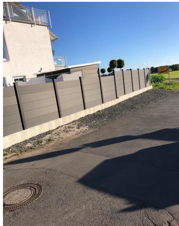
Schotterstreifen am Ende der Hauptstraße Richtung Höchst
