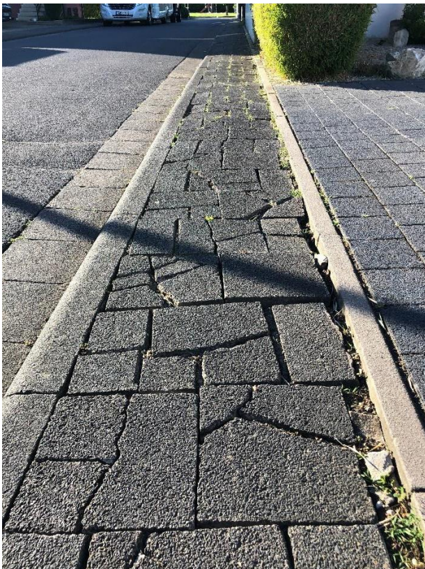
Erhöhte Unfallgefahr durch lose Gehwegplatten Am Wiesengrund 16
