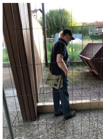
Sichtwand Trauerhalle und Prüfung Einbau einer Tür in diesem Bereich
