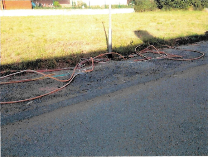
Bild 1, Glasfaserkabel, Straße Am Haferhaus
