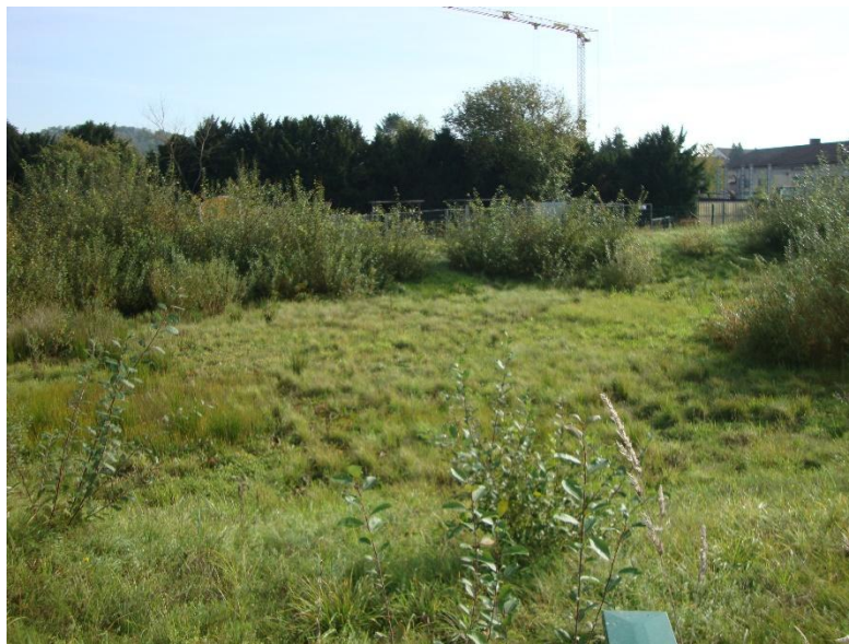
Abb. 5: Bestehende Rückhaltemulde mit jungen Salweiden an den seitlichen Böschungen. © Planungsgruppe Prof. Seifert, Oktober 2023.
