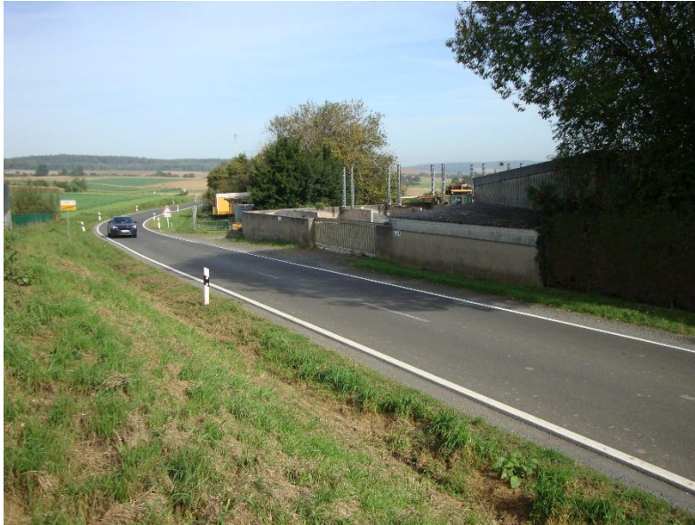
Abb. 4: Kreisstraße 297 mit seitlicher Böschung in Höhe der Rückhaltemulde. Rechts ein Baustoffbetrieb am Ortsausgang. © Planungsgruppe Prof. Seifert, Oktober 2023.
