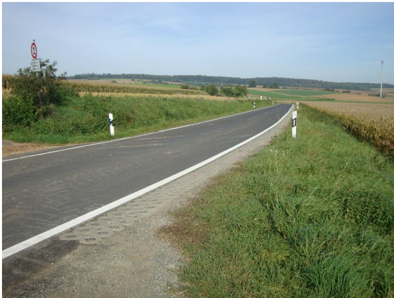
Abb. 2: Kreisstraße 297 in Blickrichtung ortsauswärts. Links der breite Randstreifen mit Böschung. © Planungsgruppe Prof. Seifert, Oktober 2023.
