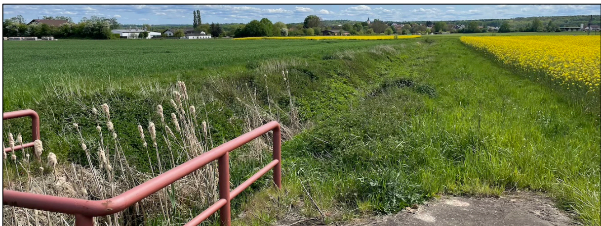
Abbildung 5: Technischer Graben mit Trapezprofil im Westen. Blicks RI SO (04/2024)
