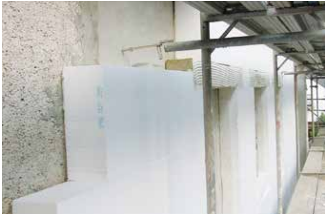
Bild 29: Wärmedämmverbundsystem mit Polystyrol
