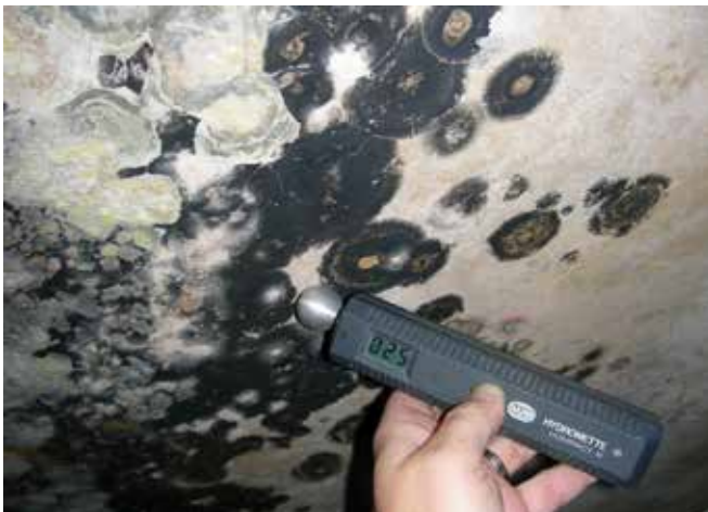
Bild 1–2: Typische Schimmelschäden
