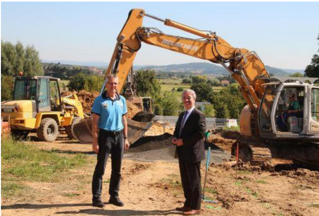
(Bauamtsleiter Volker Elbert und Bürgermeister Norbert Syguda vor Ort auf der Baustelle)
